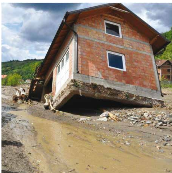
Slika 1: Prevrnuta kuća uslijed naleta bujice (lijevo) i grad Obrenovac iz zraka (desno) (preuzeto s interneta)
